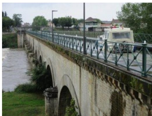
Pont Canal de Digoin
